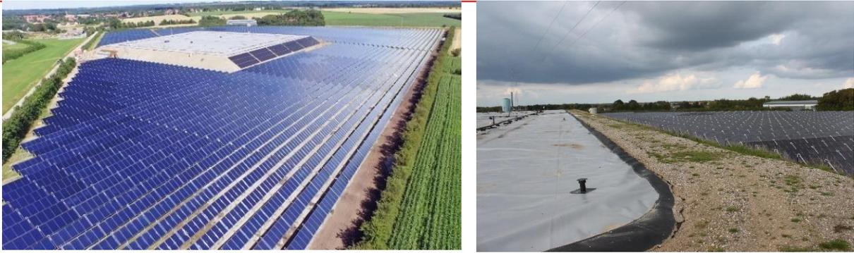
**Figura 36: Campo di collettori solari a Gram, in Danimarca, con stoccaggio stagionale dell'energia termica sotterraneo (Fonti: sinistra: Gram Fjernwärme, destra: D. Rutz)**
