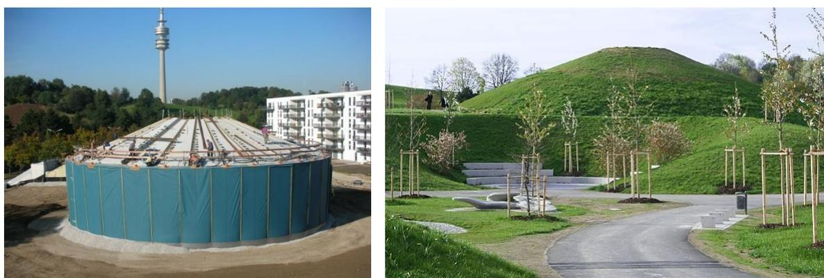
**Figura 57: Serbatoio per lo stoccaggio dell'energia termica da 5.700 m<sup>3</sup> d'acqua costruito con elementi pre-fabbricati a Monaco, in Germania (in costruzione e terminato, Fonti: Solites)**
