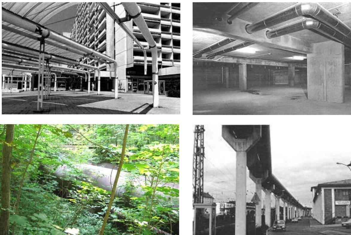
Figura 31: Esempi di tubature in superficie e sospese (Fonte: AGFW, 1987)
