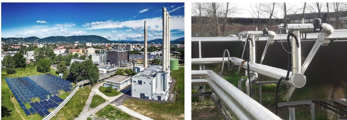
Figura 35: Campo con collettori solari termici a Graz, in Austria, che alimenta la rete di teleriscaldamento della città (Fonti: sinistra: SOLID; destra: D. Rutz)
