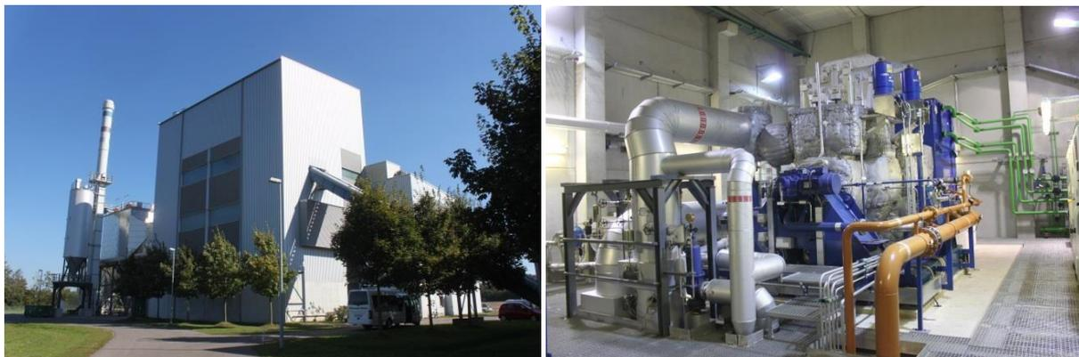
Figura 44: Centrale di cogenerazione a cippato e relativa turbina a vapore di Stadtwerke Augsburg Energie GmbH in Germania (capacità: 80.000 t/a cippato; 7,8 MW<sub>el</sub>; 15 MW<sub>th</sub>) (Fonti: D. Rutz)
