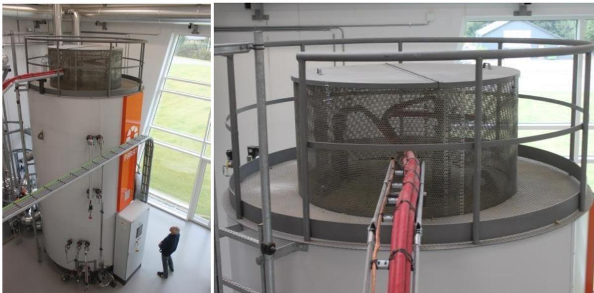
Figura 51: Caldaia a elettrodi da 10 MW e 14,4 m<sup>3</sup> di capacità, centrale di teleriscaldamento solare di Gram, in Danimarca (Fonte: D. Rutz)
