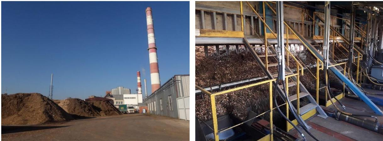
Figura 42: Centrale di cogenerazione di Salcininkai, in Lituania, dove la caldaia a biomassa (5 MWh) ha sostituito una delle tre unità di cogenerazione a gas naturale. Le due unità rimanenti hanno una capacità di 3,5 MW<sub>th</sub> e 6 MW<sub>th</sub> (Fonti: D. Rutz)
