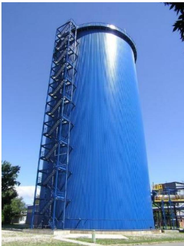
**Figura 55: Stoccaggio termico non pressurizzato del sistema TLR di Zagabria (Fonte: [www.pogledaj.to](http://www.pogledaj.to))**
