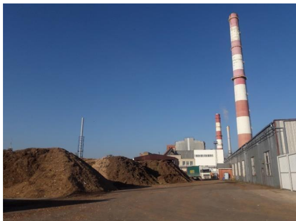
Figura 42: Centrale di cogenerazione di Salcininkai, in Lituania, dove la caldaia a biomassa (5 MW th ) ha sostituito una delle tre unità di cogenerazione a gas naturale. Le due unità rimanenti hanno una capacità di 3,5 MW th e 6 MW th (Fonti: D. Rutz)
