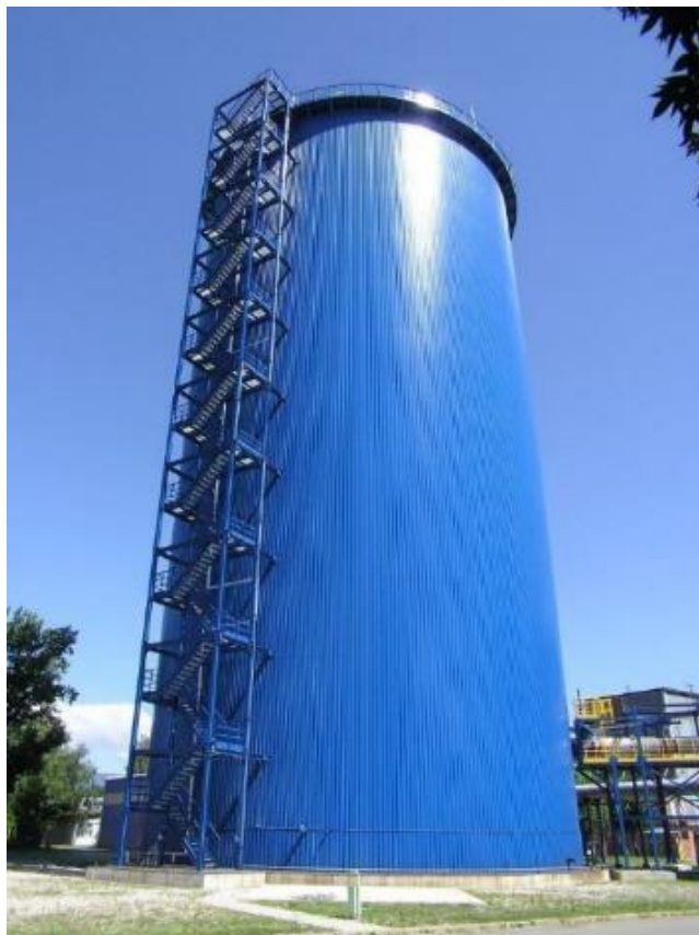
Figura 55: Stoccaggio termico non pressurizzato del sistema TLR di Zagabria (Fonte: www.pogledaj.to )
