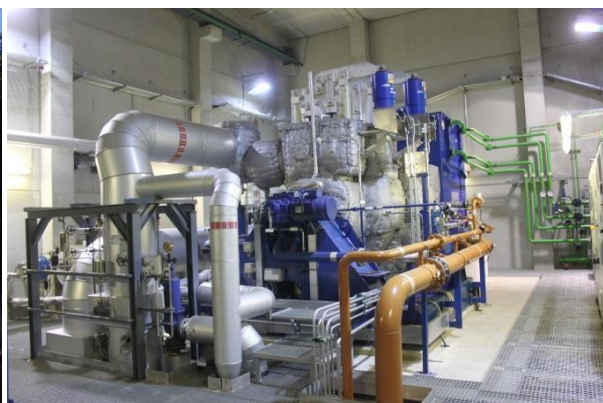
Figura 44: Centrale di cogenerazione a cippato e relativa turbina a vapore di Stadtwerke Augsburg Energie GmbH in Germania (capacità: 80.000 t/a cippato; 7,8 MW el ; 15 MW th ) (Fonti: D. Rutz)
