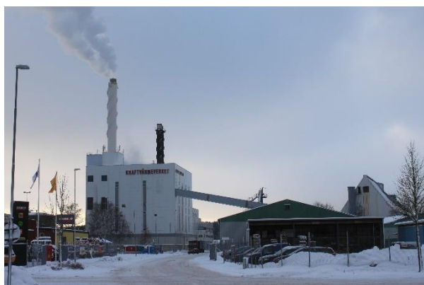
Figura 43: Centrale di cogenerazione di Ena Energie a Enköping, che utilizza cippato da legno di scarto (destra) e da bosco ceduo a rotazione rapida (Fonti: D. Rutz)
