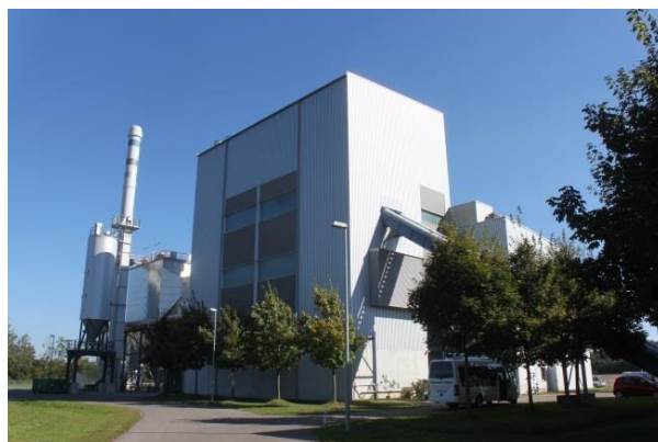
Figura 44: Centrale di cogenerazione a cippato e relativa turbina a vapore di Stadtwerke Augsburg Energie GmbH in Germania (capacità: 80.000 t/a cippato; 7,8 MW el ; 15 MW th ) (Fonti: D. Rutz)
