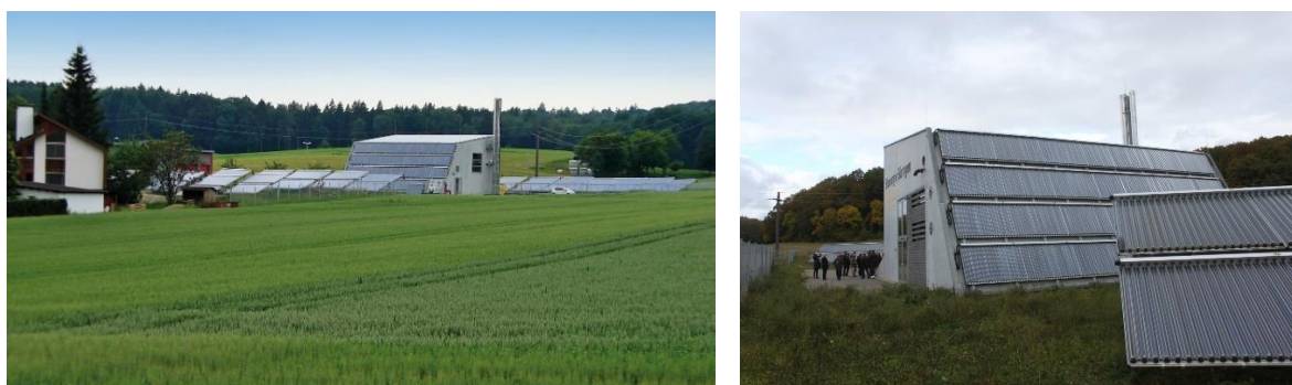
Figura 34: Impianto di riscaldamento con collettori solari termici nella cittadina di Büsingen, in Germania (Fonti: sinistra: Solites; destra: D. Rutz)
