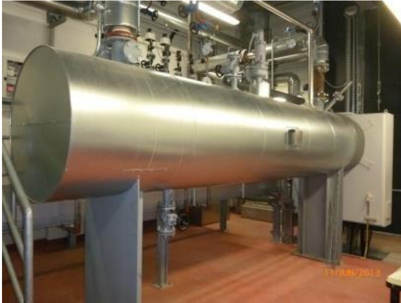
Figura 53: Riscaldatore di flusso elettrico (Fonte: Klöpper-Therm GmbH & Co.KG)
