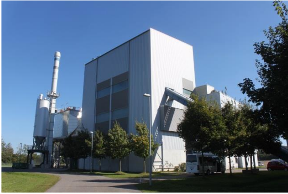
Slika 44: Kogeneracijsko postrojenje pogonjeno drvnom sječkom i pripadajuća parna turbina (kapacitet: 80.000 tona drvene sječke godišnje; 7.8 MWel; 15 MWth), Stadtwerke Augsburg Energie GmbH u Njemačkoj (Izvor: D. Rutz)
