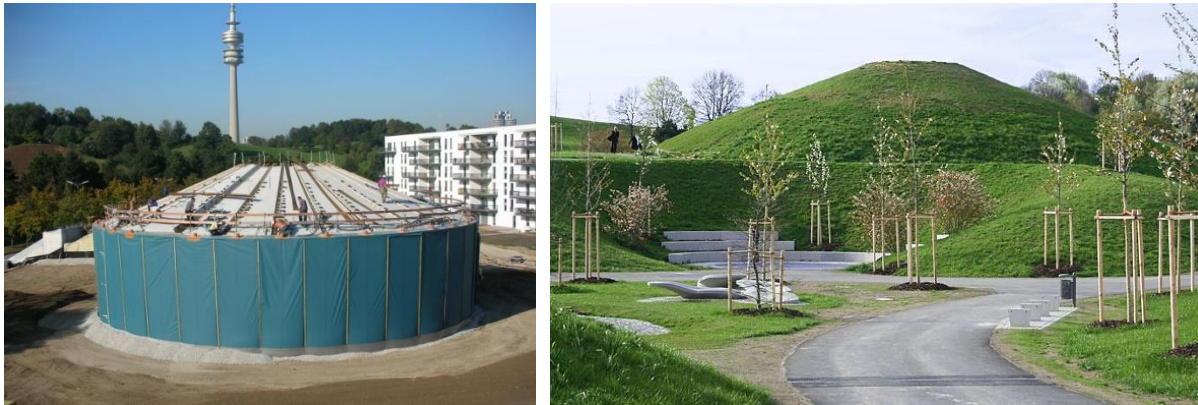
Slika 57: Spremnik za pohranu toplinske energije zapremnine 5.700 m 3 iz pred-izrađenih betonskih elemenata, München, Njemačka (tokom izgradnje – lijevo, gotov- desno, Izvor: Solites)
