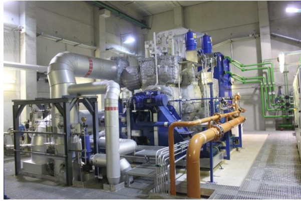
Slika 44: Kogeneracijsko postrojenje pogonjeno drvnom sječkom i pripadajuća parna turbina (kapacitet: 80.000 tona drvene sječke godišnje; 7.8 MWel; 15 MWth), Stadtwerke Augsburg Energie GmbH u Njemačkoj (Izvor: D. Rutz)
