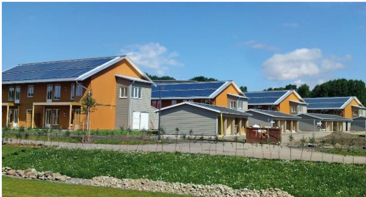
Slika 33: Solarni CTS u stambenoj četvrti Vallda Heberg u Švedskoj (Izvor: Jan-Olof Dalenbäck)
