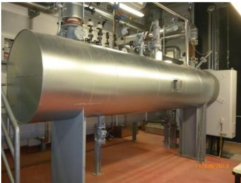
Slika 53: Električni protočni grijač (Izvor: Klöpper-Therm GmbH i Co.KG)
