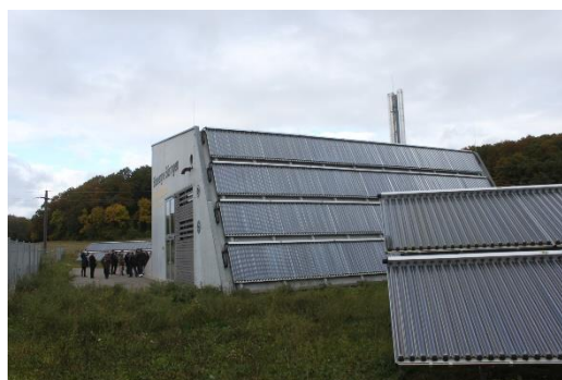
Slika 34: Proizvodno postrojenje s solarnim kolektorima u naselju Büsingen u Njemačkoj (Izvor: lijevo: Solites; desno: D. Rutz)
