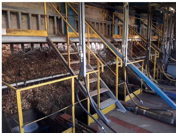
Slika 42: Kogeneracijsko postrojenje u kojem se instalacijom kotla na biomasu snage 5 MW th zamijenio jedan kogeneracijski blok na prirodni plin. Preostala dva kogeneracijska bloka imaju toplinske snage od 3.5 MW th i 6 MW th , Salcininkai, Litva (Izvor: D. Rutz)
