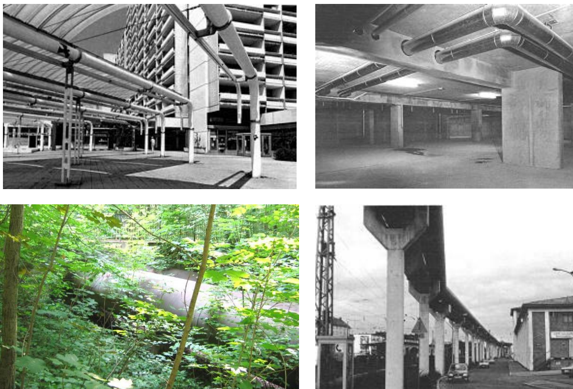
Slika 31: Primjeri nadzemnih i stropnih toplovoda (Izvor: AGFW, 1987)
