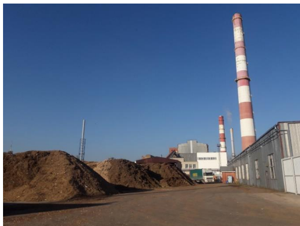
Slika 42: Kogeneracijsko postrojenje u kojem se instalacijom kotla na biomasu snage 5 MW th zamijenio jedan kogeneracijski blok na prirodni plin. Preostala dva kogeneracijska bloka imaju toplinske snage od 3.5 MW th i 6 MW th , Salcininkai, Litva (Izvor: D. Rutz)
