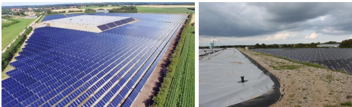
Slika 36: Polje solarnih toplinskih kolektora i sezonski toplinski spremnik u obliku jame, Gram, Danska (Izvor: lijevo: Gram Fjernwärme, desno: D. Rutz)
