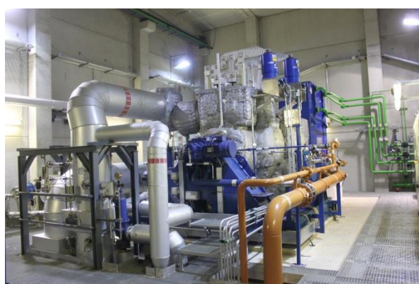
Rysunek 44: Elektrociepłownia opalana wiórami drzewnymi i turbina parowa Stadtwerke Augsburg Energie GmbH w Niemczech (wydajność: 80 000 t/wióry drzewne; 7,8 MW el ; 15 MW th ) (źródła: D.Rutz)
