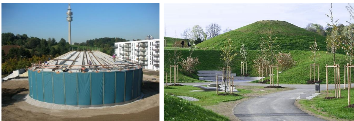
Rysunek 57: Zbiornik magazynujący energię cieplną o objętości 5700m 3 wody zbudowanej z prefabrykowanych elementów betonowych w Monachium w Niemczech (w budowie po lewej i sfinalizowany po prawej, źródła: Solites)
