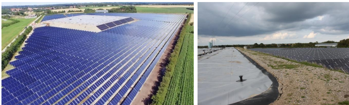
Rysunek 36: Pole kolektorów słonecznych w Gram w Danii, z sezonowym magazynowaniem energii cieplnej (Źródła: po lewej: Gram Fjernwärme, po prawej: D. Rutz) pit thermal energy
