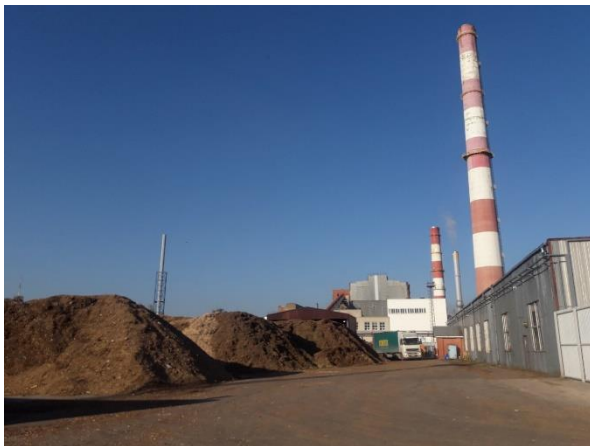
Rysunek 42: Elektrociepłownia w Salcininkai na Litwie, w której kocioł na biomasę (5 MWth) zastąpił jedną z trzech jednostek kogeneracyjnych na gaz ziemny. Pozostałe dwie gazowe jednostki kogeneracyjne mają moc 3,5 MWth i 6 MWth (Źródła: D. Rutz)
