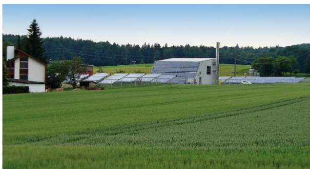
Rysunek 34: Ciepłownia z kolektorami słonecznymi w miejscowości Büsingen, Niemcy (Źródła: po lewej: Solites; po prawej: D. Rutz)
