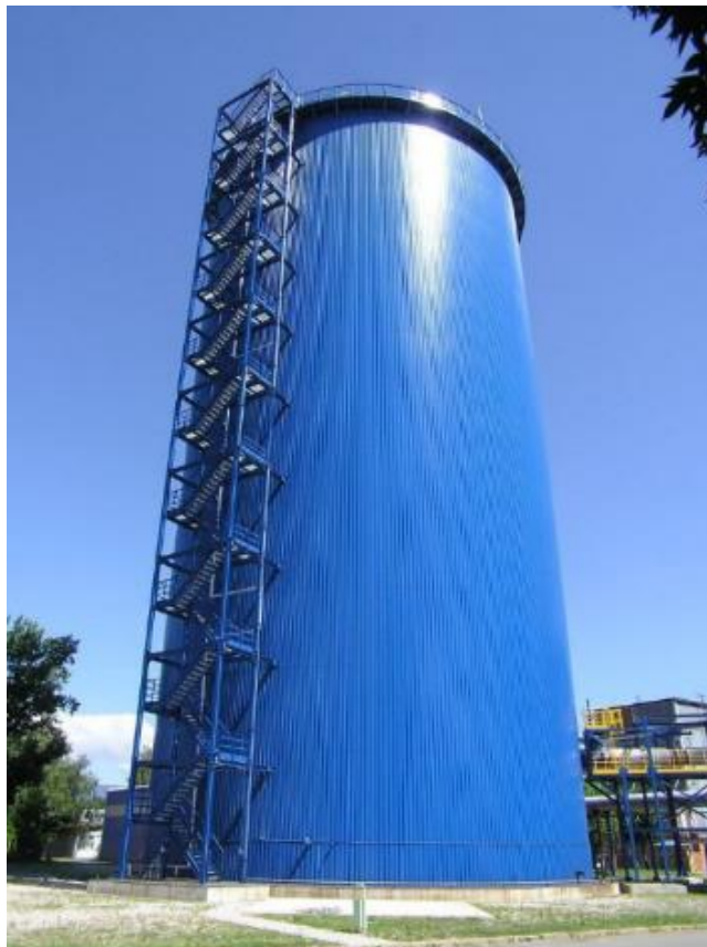
Rysunek 55: Zbiornik do przechowywania ciepła pracujący przy ciśnieniu atmosferycznym w systemie ciepłowniczym w Zagrzebiu (Źródło: www.pogledaj.to )
