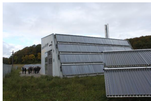
Rysunek 34: Ciepłownia z kolektorami słonecznymi w miejscowości Büsingen, Niemcy (Źródła: po lewej: Solites; po prawej: D. Rutz)
